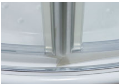
■ Prahová lišta a spodní těsnění dveří
