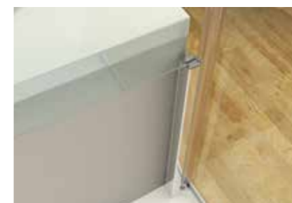
Detail napojení zkrácené boční stěny k vaně
