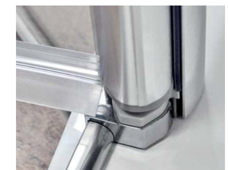
Durų pakėlimo mechanizmas, apatinė durų tarpinė ir slenktis
