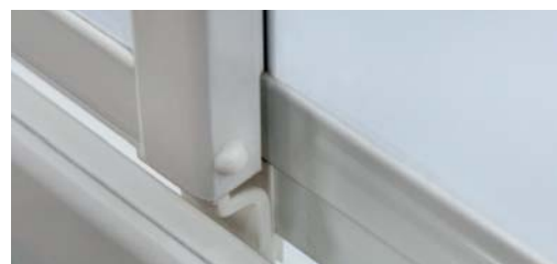
Spodné odklápanie dverí pre ľahšiu údržbu sprchových dverí
