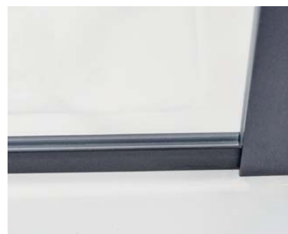
■ Ochronny profil aluminiowy na dolnej krawędzi szkła
