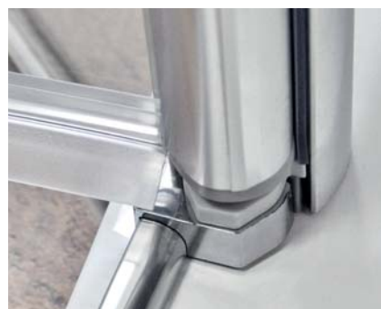
■ Durvju pacelšanas mehānisms, sliekšnis un starplikas
